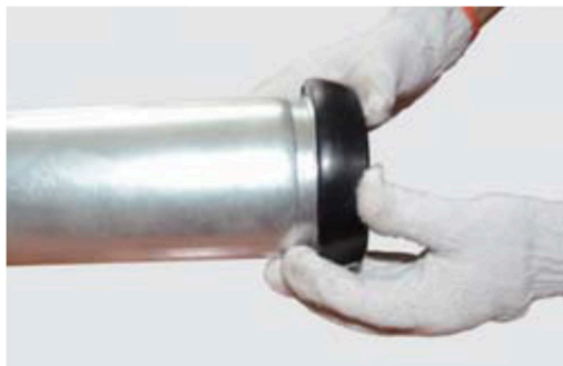
Inserimento della guarnizione
