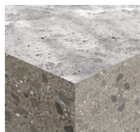
Calcestruzzo non fessurato
