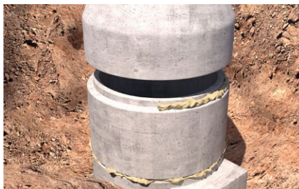
Sigillatura anelli di pozzetti di calcestruzzo.
